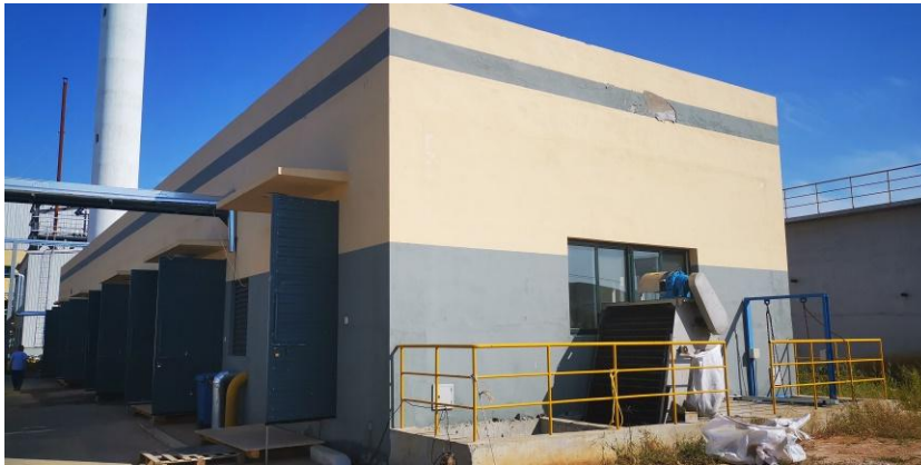
厂区现有污水处理站
