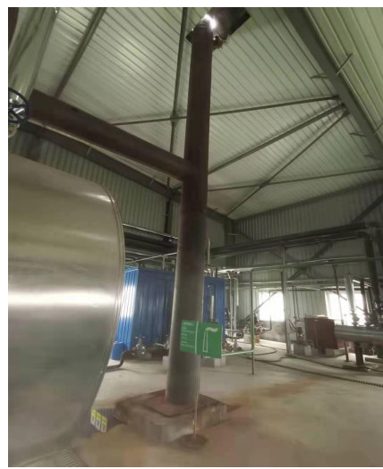
4t 锅炉及锅炉排气筒
