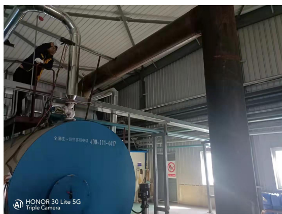
DA004 排气筒规范采样口
