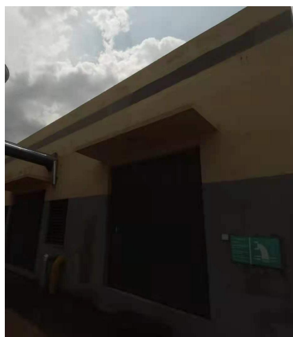
DW001 废水处理站
