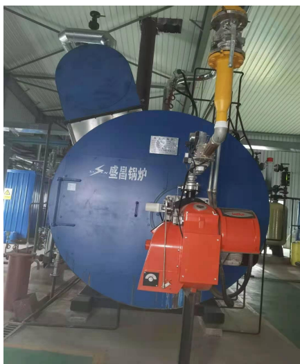
4t 锅炉及锅炉排气筒
