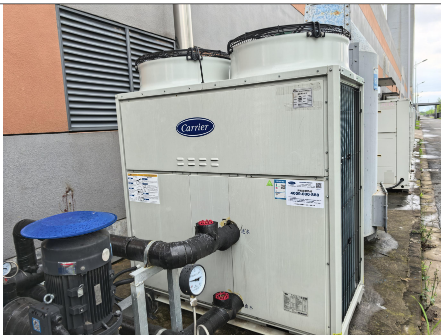
图 3-6 本项目涡旋式风冷冷水机组
