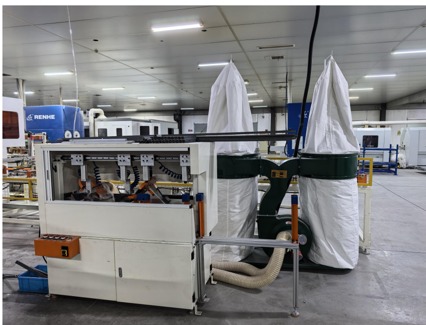
图 3-9 本项目小型切角机及配套的双桶布袋除尘器
