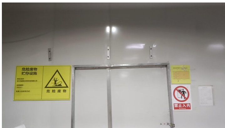
图 3-12 本项目危废暂存间
